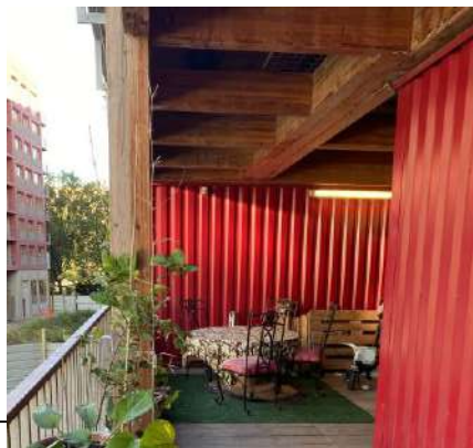
Coursive aménagée en salon-palier
